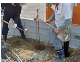
① 規定通りアース棒を打設
