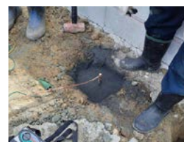
③ 敷設完了
