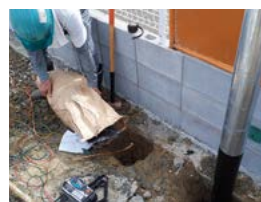
② カーボンアースを敷設
