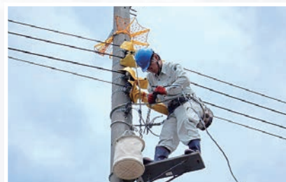
東北電力引込線工事作業訓練
