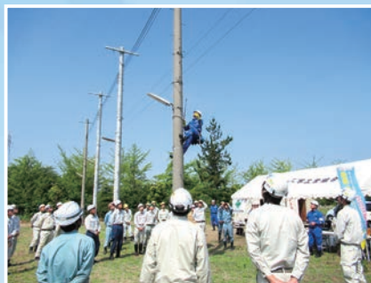
〈引込線実技訓練〉 電柱で安全に作業を行うための訓練
