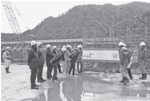
豊実水力発電所改修工事を見学
