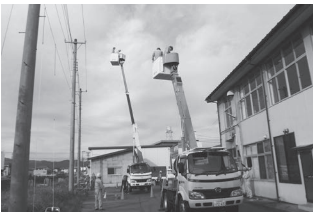
高所作業車運転技能講習
