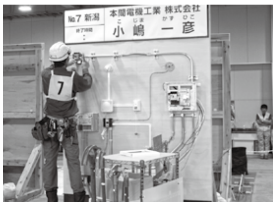
機器への接続作業
