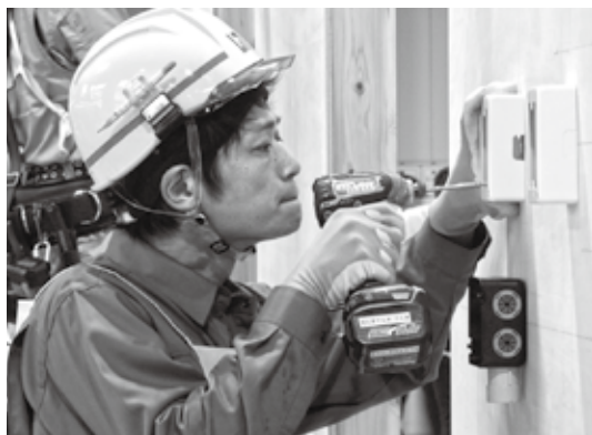
メタルモールボックス施工作業
