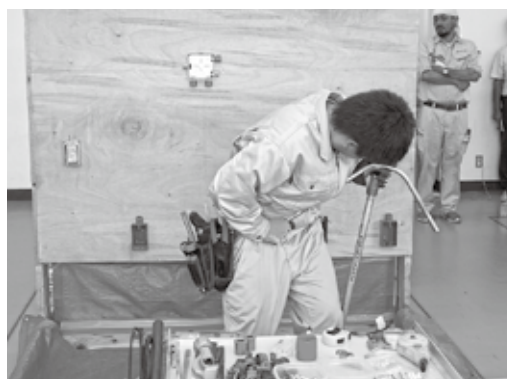
金属管曲げ作業
