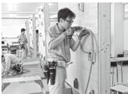
サドル取付け作業
