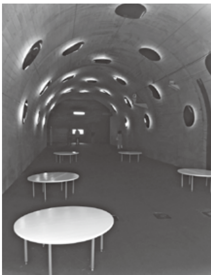
清津峡トンネル
