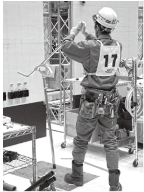
金属管曲げ作業
