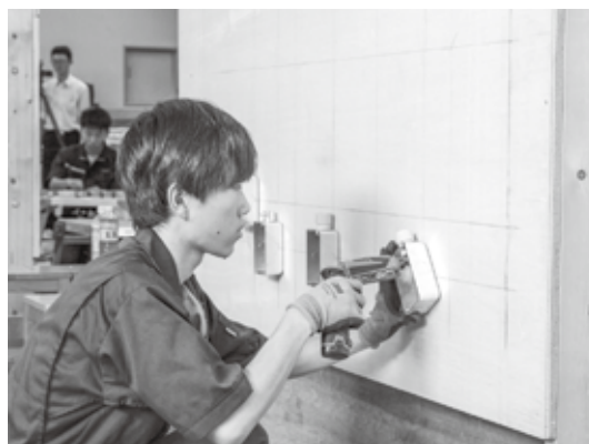
ボックス取付作業
