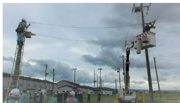
先行して空分引込線張替工事を施工している 新潟引込線工事㈱さんによる模範演技
