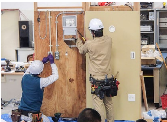
模擬パネルへの施工
