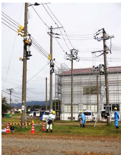
引込線工事実技訓練
