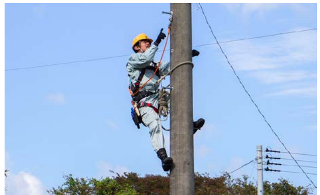
引込線実技技能認定審査
